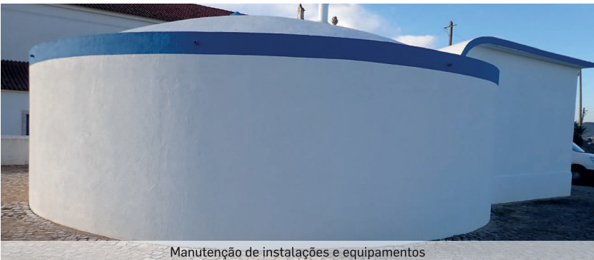
Manutenção de instalações e equipamentos
