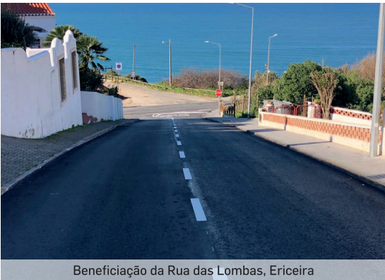
Beneficiação da Rua das Lombas, Ericeira
