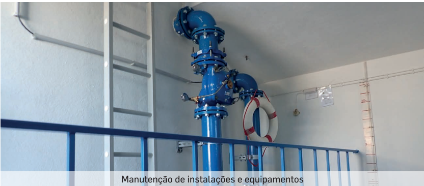
Manutenção de instalações e equipamentos
