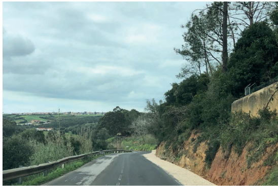
Alargamento e pavimentação da EM616, Sto. Isidoro/ Cabeça Alta
