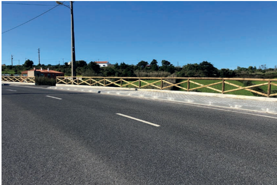
Construção de passeio Carvoeira/ Baleia
