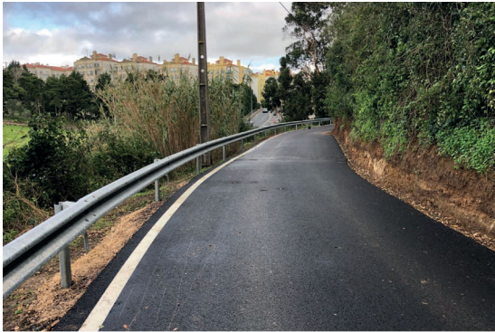
Pavimentação da R. Fonte de Mafra e R. do Alto da Fonte de Mafra
