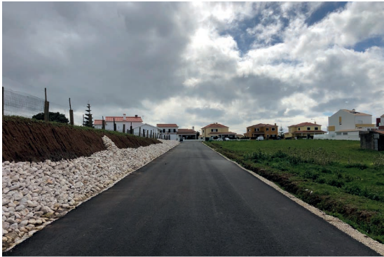
Alargamento da Rua Vasco Marques, Mafra
