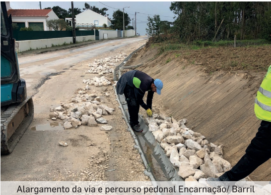
Alargamento da via e percurso pedonal Encarnação/ Barril
