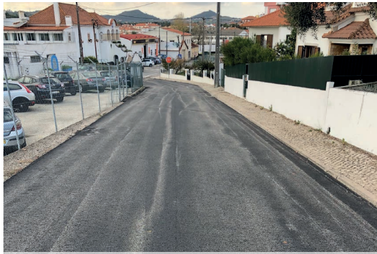
Pavimentação da Rua do Progresso, Póvoa da Galega
