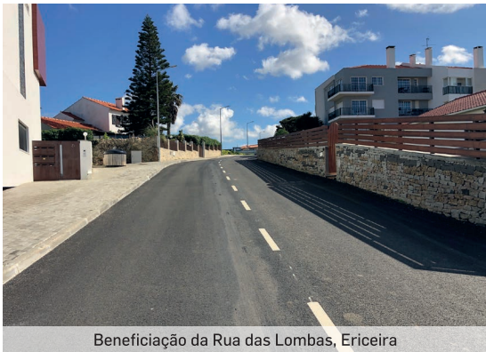
Beneficiação da Rua das Lombas, Ericeira
