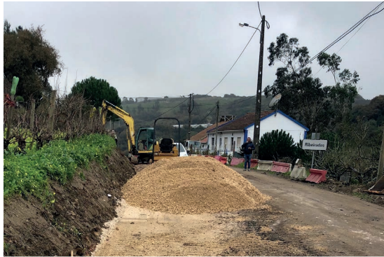
Alargamento da estrada Cachoeira/ Ribeiradas
