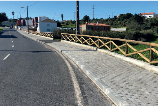
Construção de passeio Carvoeira/ Baleia
