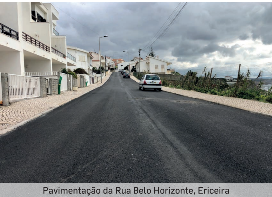
Pavimentação da Rua Belo Horizonte, Ericeira
