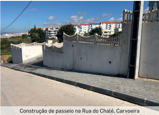
Construção de passeio na Rua do Chale, Carvoeira
