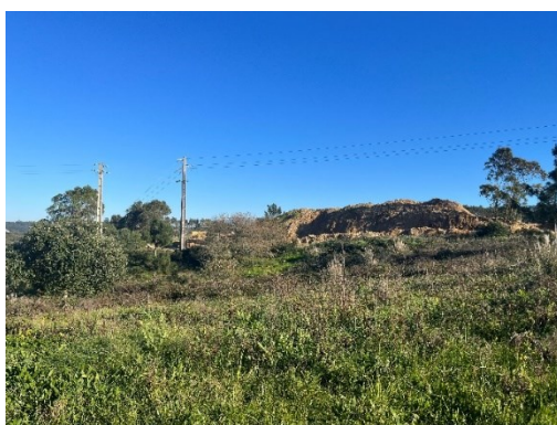
Figura 4 – Realização de obras de contenção.
