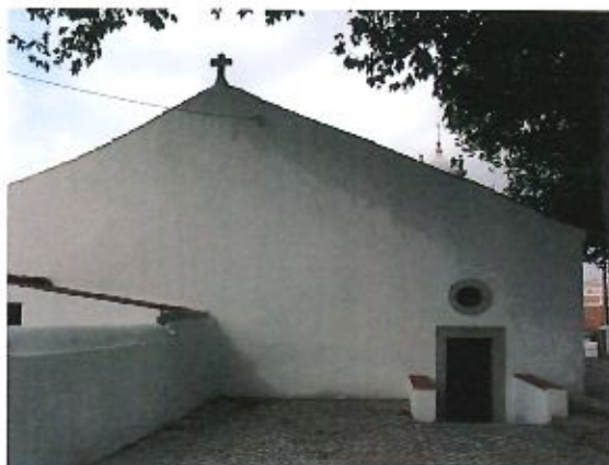
Fig. 14. Fachada nascente, porta retangular encimada por óculo circular, desnivelada.
