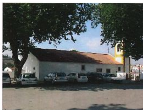
Fig. 15. Fachada Norte observa-se uma porta de moldura retangular junto ao muro do adro e 2 janelas retangulares.
