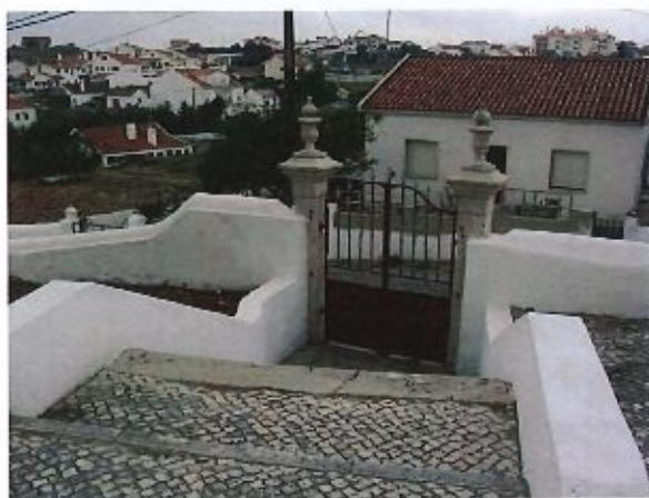
Fig. 11. Adro murado em declive para oeste, com portão de ferro entre pilares encimados por fogaréus.
