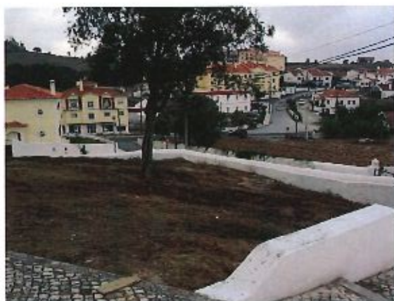
Fig. 12. Adro murado em declive para oeste.
