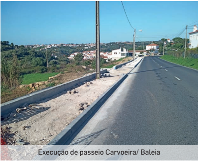
Execução de passeio Carvoeira/ Baleia
