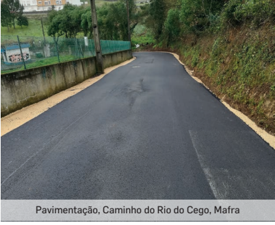
Pavimentação, Caminho do Rio do Cego, Mafra
