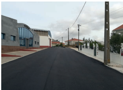
Pavimentação de arruamentos, Igreja Nova
