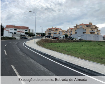
Execução de passeio, Estrada de Almada
