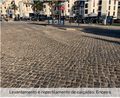
Levantamento e reperfilamento de calçadas, Ericeira
