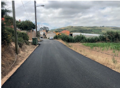
Pavimentação, EM619 de ligação da EN9-2 a São Sebastião
