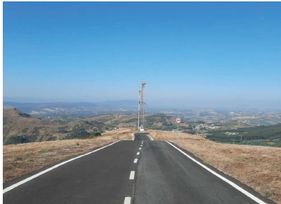
Pavimentação do acesso à Serra do Socorro
