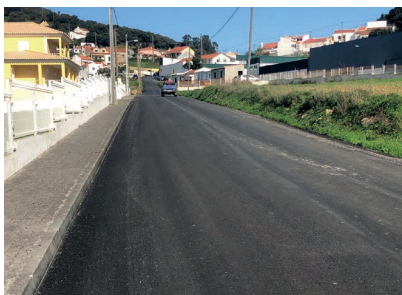
Pavimentação de arruamentos, Montemuro
