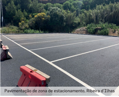
Pavimentação de zona de estacionamento, Ribeira d'Ilhas
