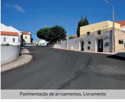
Pavimentação de arruamentos, Livramento
