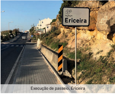
Execução de passeio, Ericeira
