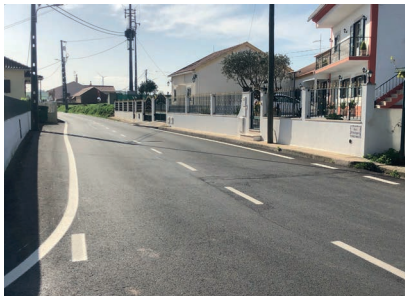
Pavimentação de arruamentos, Ervideira
