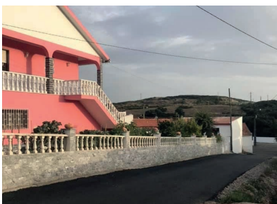
Pavimentação de arruamento, Abrunheira
