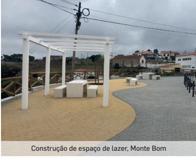
Construção de espaço de lazer, Monte Bom
