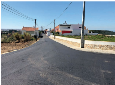
Pavimentação de arruamentos, Ventureira
