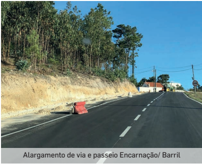
Alargamento de via e passeio Encarnação/ Barril
