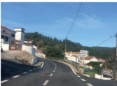
Alargamento e repavimentação da EM539, Rogel/ Galés
