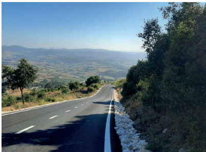
Pavimentação do acesso à Serra do Socorro
