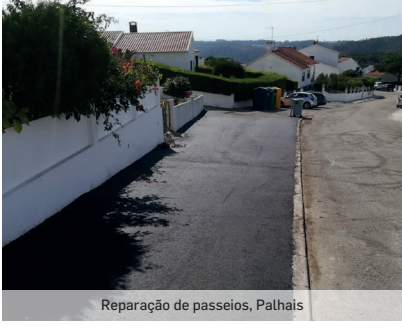
Reparação de passeios, Palhais
