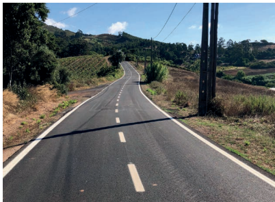
Pavimentação, CM1174, Estrada das Boiças
