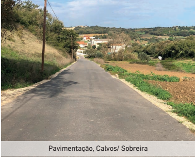
Pavimentação, Calvos/ Sobreira
