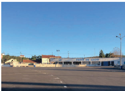
Pavimentação do Largo da Ermida, Malveira
