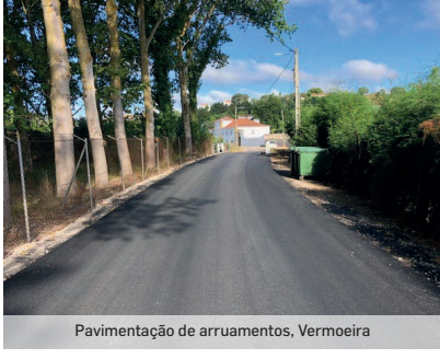
Pavimentação de arruamentos, Vermoeira
