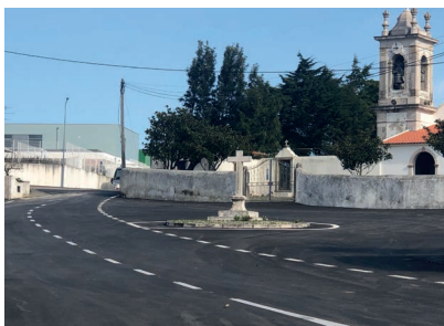
Alargamento e repavimentação da EM539, Rogel/ Galés
