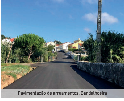
Pavimentação de arruamentos, Bandalhoeira
