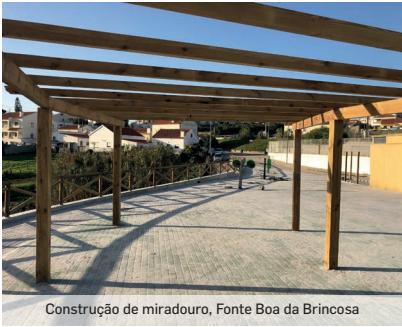
Construção de miradouro, Fonte Boa da Brincosa
