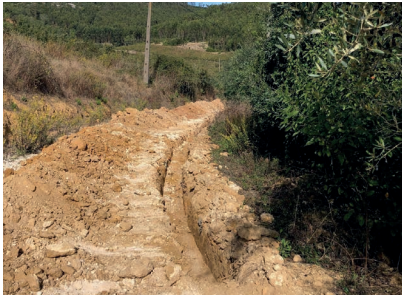
Execução de rede de abastecimento de água, Casal do Mota
