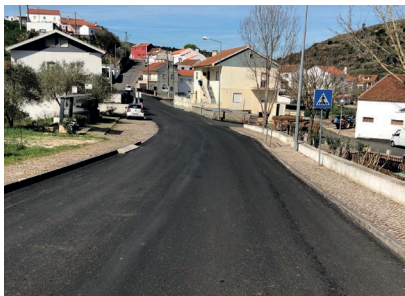
Pavimentação de arruamentos, Carvalhal
