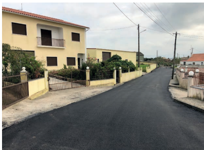
Pavimentação de arruamentos, Arroeiros
