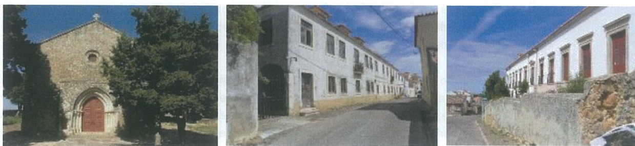
Figura 5| Igreja de Santo André. Antigo edifício da Santa Casa da Misericórdia. Palácio dos Marqueses de Ponte de Lima.
