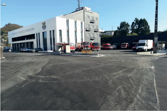
Pavimentação, R. Bombeiros Voluntários, Malveira
