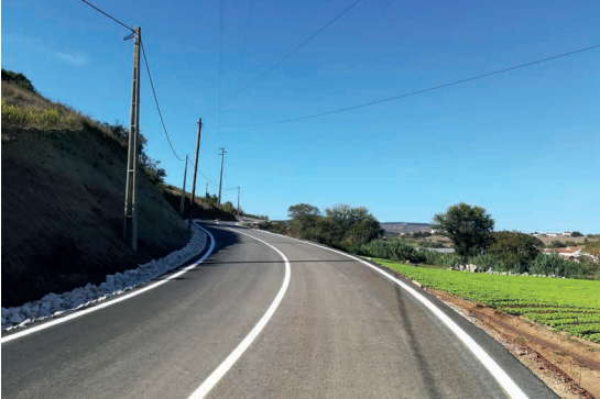
Pavimentação, Caminho de Reguengos
