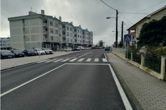
Pavimentação da Av. Sá Carneiro, Mafra
