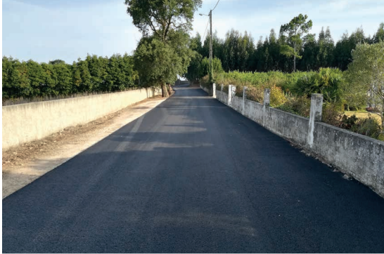
Pavimentação, Poço da Serra, Mafra
