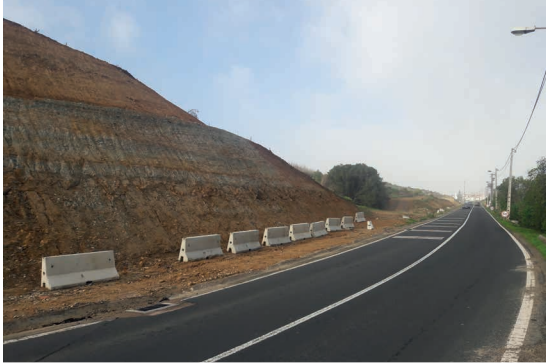
Construção do passeio Ribeira d'Ilhas/ Ribamar
