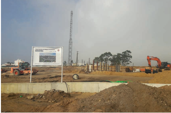
Construção do Parque Intermodal da Ericeira
