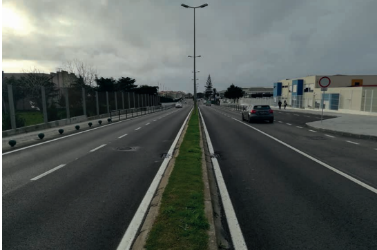
Pavimentação da Av. Sá Carneiro, Mafra
