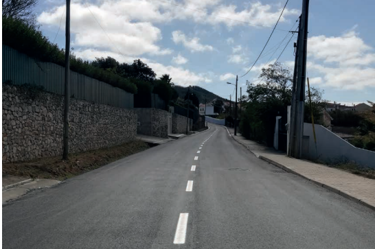
Pavimentação, Caminho de Reguengos
