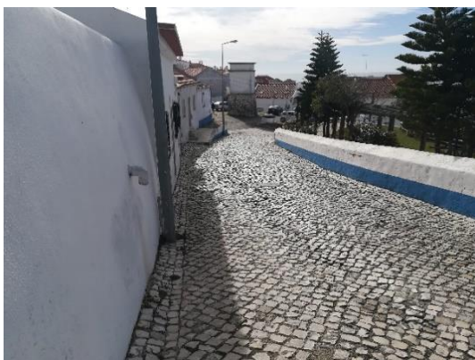
Figura 79 | Calçada do Rêgo
