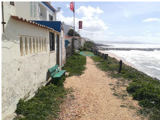
Figura 96 | Rua da Falésia do Algodio. Sentido Norte - Sul
