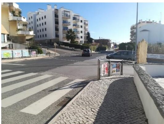
Figura 73 | Interseção da Rua Henrique Pereira com a Estrada Regional 247
