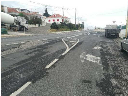
Figura 85 | Interseção. Vista Norte - Sul
