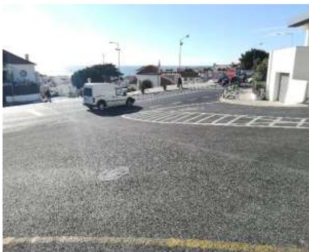
Legenda: Interseção. Vista da Estrada de Mafra. Sentido Este - Oeste
