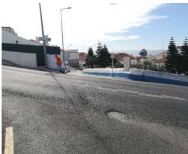
Legenda: Interseção. Vista da Estrada do Rêgo. Sentido Este - Oeste
