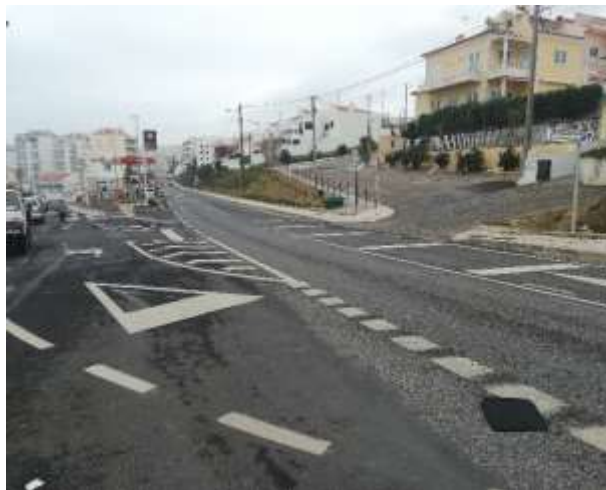
Legenda: Interseção. Vista da Rua Doutor Eduardo Burnay. Sentido Sul - Norte
