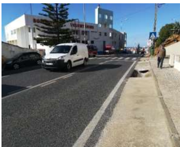
Legenda: Interseção. Vista dos Bombeiros Voluntários. Sentido Sul - Norte
