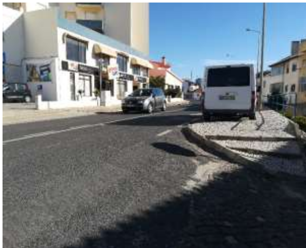
Legenda: Interseção. Vista da Rua do Mercado. Sentido Norte - Sul
