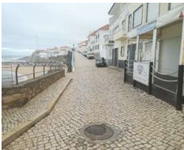
Legenda: Rua Capitão João Lopes. Sentido Sul - Norte
