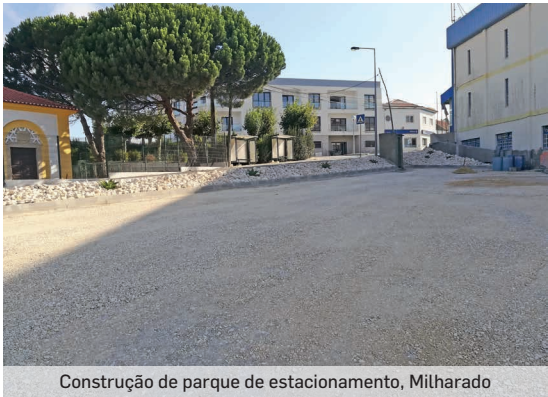
Construção de parque de estacionamento, Milharado
