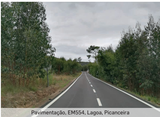
Pavimentação, EM554, Lagoa, Pínceira
