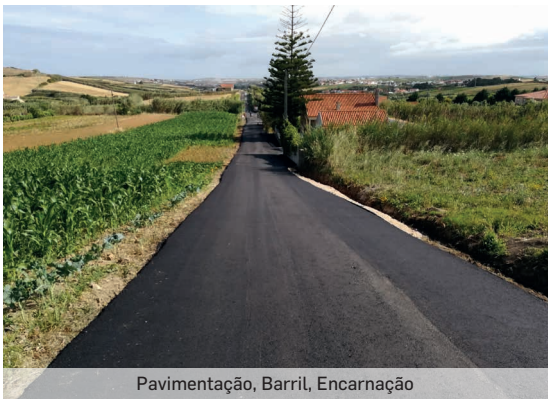
Pavimentação, Barril, Encarnação
