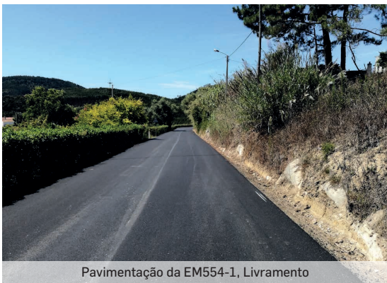
Pavimentação da EM554-1, Livramento
