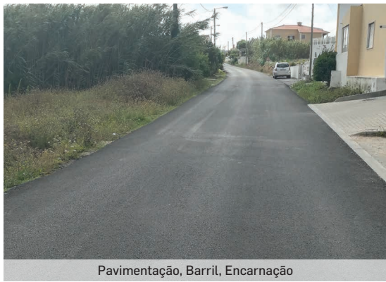
Pavimentação, Barril, Encarnação
