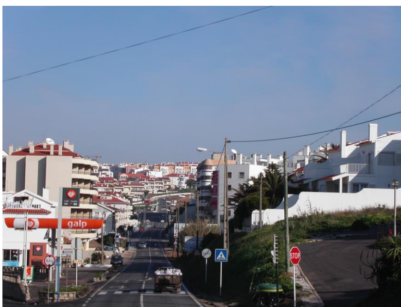
Fotografia 6.1 – Estrada Nacional 247 (acesso ao centro urbano da Ericeira)
