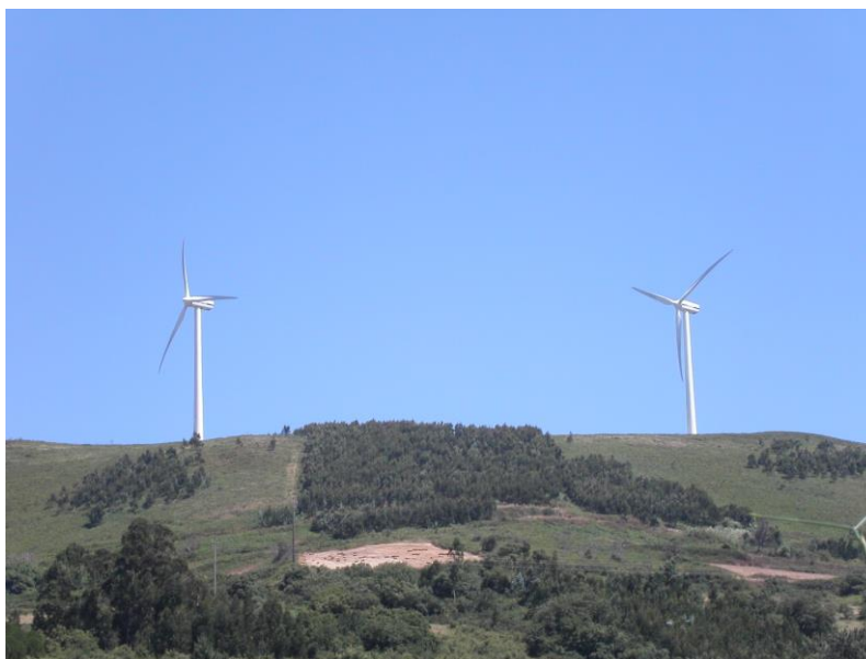
Fotografia 4.2 - Parque Eólico da Serra do Funchal
