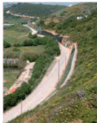
Figura 5: Vista do talude Sul, durante os trabalhos de estabilização em Maio de 2012.
