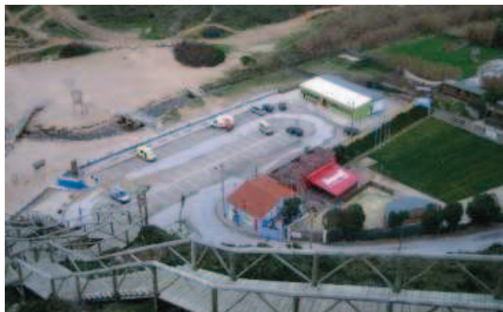
Figura 1: Vista da zona de apoio à praia de Ribeira de Ilhas.
