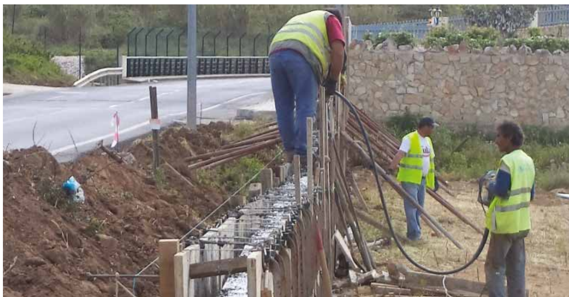
Construção de passeios e alargamento da EM 549 Mafra/ Quintal
