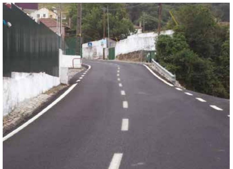
Pavimentação da EM 539 Asseiceira Pequena - Venda do Pinheiro
