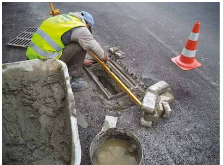
Trabalhos preparatórios e pavimentação Ericeira/ Cabeça Alta
