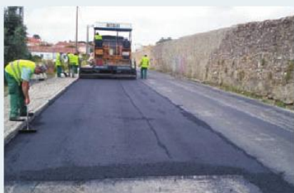
Construção de muro e passeio e pavimentação - Paz
