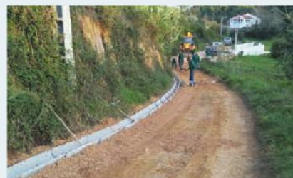
Construção de valetas Rua do Ulmeiro, Monte Bom
