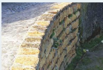
Construção de muralha Asseiceira Pequena
