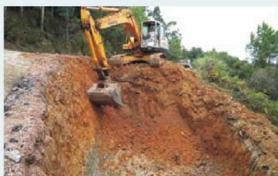
Reparação de estrada Casal da Amoreira
