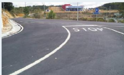
Construção de infra-estruturas de acesso ao novo quartel dos Bombeiros Voluntários de Mafra
