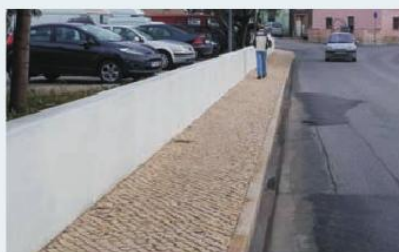
Construção de muro e passeio Malveira
