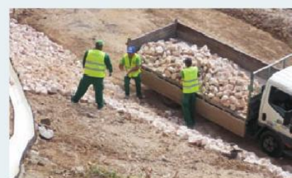
Construção de muralha Carapinheira, Igreja Nova
