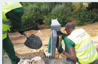
Colocação de rails de protecção Estrada Sobral da Abelheira/ Codeçal
