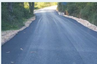
Pavimentação Caminho de acesso ao Centro de Recuperação do Lobo Ibérico
