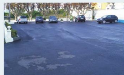
Pavimentação Estacionamento junto ao cemitério da Ericeira
