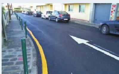
Pavimentação Rua da Parreira, Mafra
