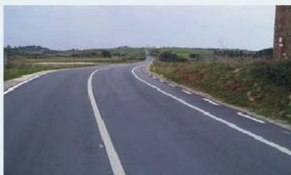
Pavimentação Estrada Santo Isidoro/ Lagoa
