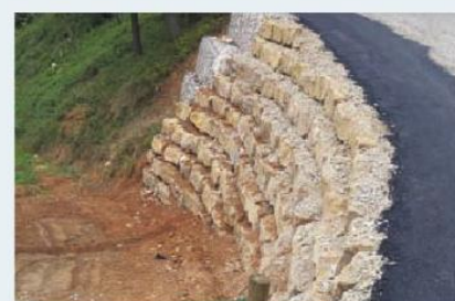
Construção de muralha Estrada Sobral da Abelheira/ Codeçal
