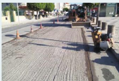
Pavimentação Rua 1.º de Maio, Mafra
