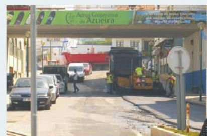
Pavimentação Largo dos Navegantes, Ericeira
