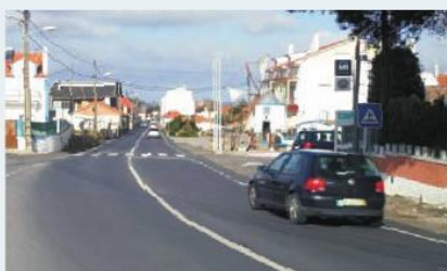
Pavimentação (após saneamento) EN116 Sobreiro
