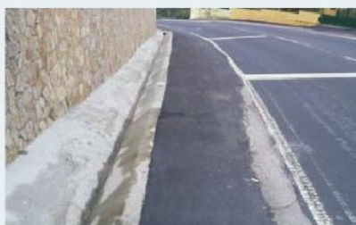
Construção de valetas em betão Charneca
