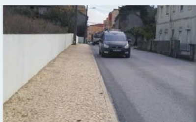
Construção de muro e passeio Malveira
