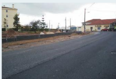
Construção de muro e passeio (junto ao antigo edifício da GNR) Malveira
