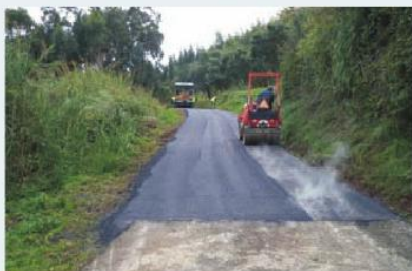
Pavimentação Portela, Gradil
