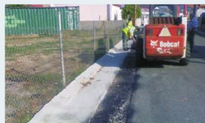
Construção de valetas Casais da Areia
