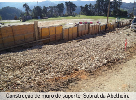
Construção de muro de suporte, Sobral da Abelheira
