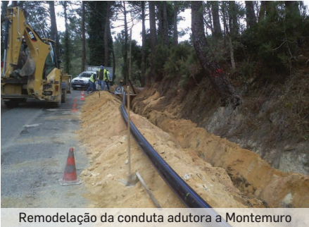
Remodelação da conduta adutora a Montemuro
