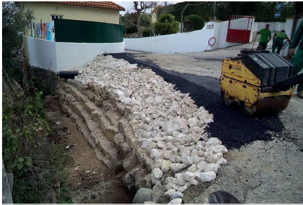
Construção de muro de suporte, Vale de S. Gião
