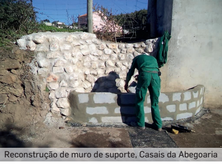
Reconstrução de muro de suporte, Casais da Abegoaria
