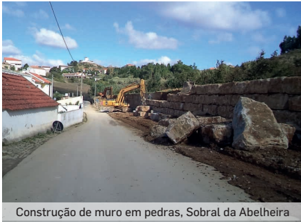
Construção de muro em pedras, Sobral da Abelheira
