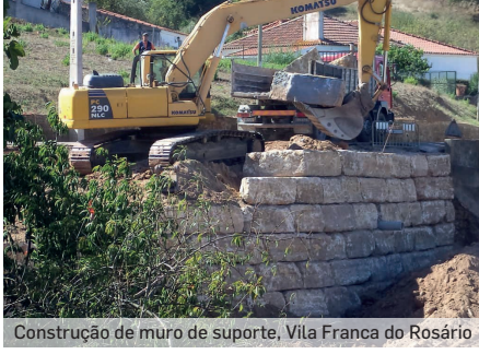
Construção de muro de suporte, Vila Franca do Rosário
