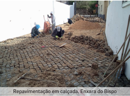
Repavimentação em calçada, Enxara do Bispo
