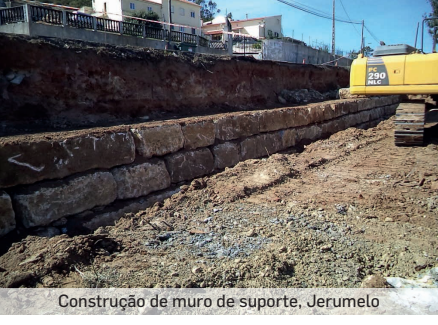
Construção de muro de suporte, Jerumelo
