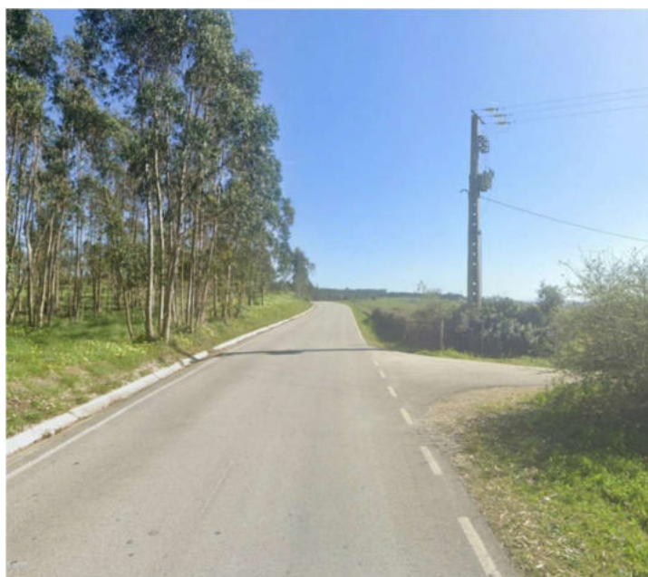
Figura 40: Estrada dos Fortes (CM 1164) Junto à Entrada da Propriedade
