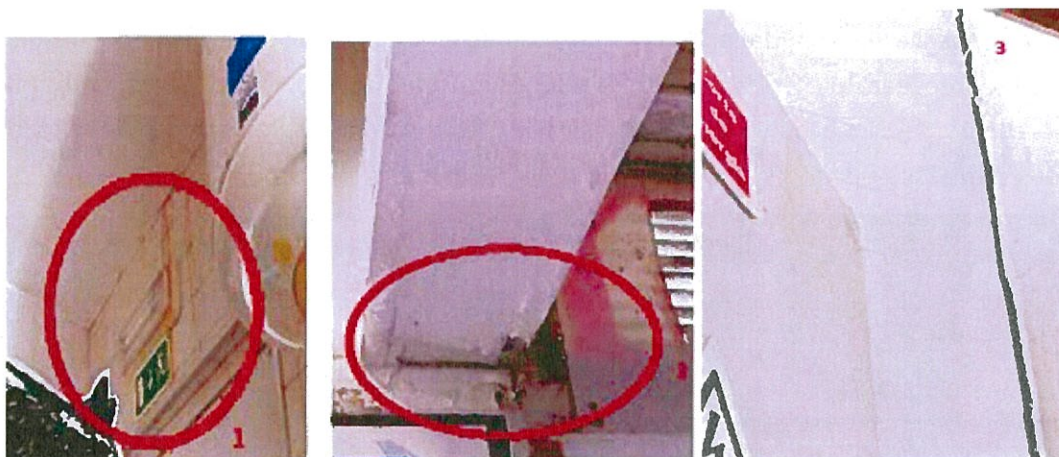
Fig. 1.27 / 1.28 / 1.29 – Cozinha – presença de eflorescências (1), deterioração do estuque (2) e fissura no revestimento cerâmico na cozinha (3)
