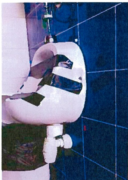
Fig. 1.35 / 1.36 – Casas de banho – Urinol (1) e sinais de ferrugem (2)
