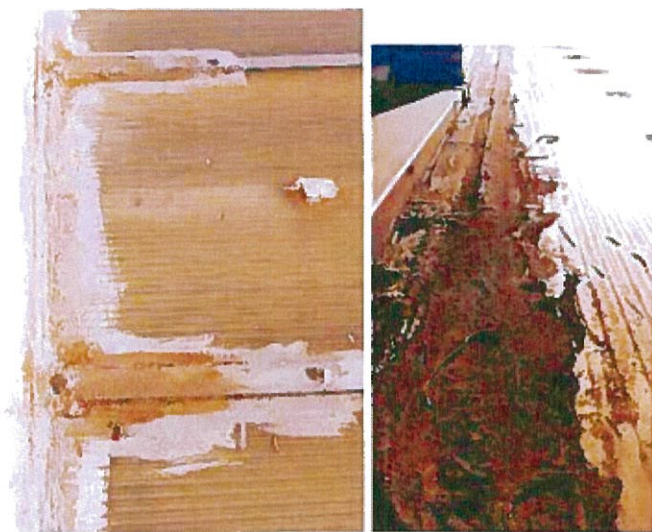
Fig. 1.14 - Pormenores de zonas de maior fragilidade das placas de policarbonato: remates com platibandas
