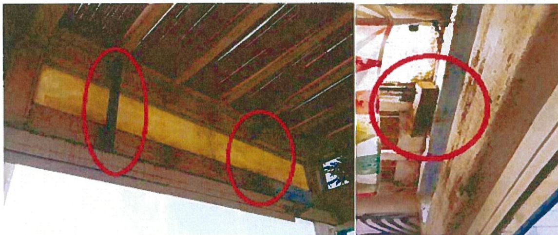
Fig. 1.23 / 1.24 – Estrutura – fachada principal: zonas em que as vigas de madeira estão mais debilitadas
