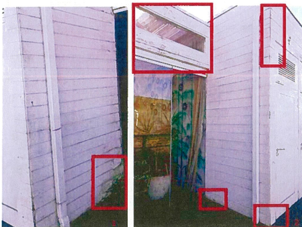
Fig. 1.4 / 1.5- Fachada tardoz com madeira apodrecida (1) e sinais de humidade (2)
