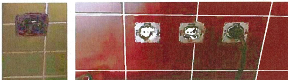
Fig. 1.46 / 1.47 – Pontos de utilização: Tomadas sem proteção (1)
