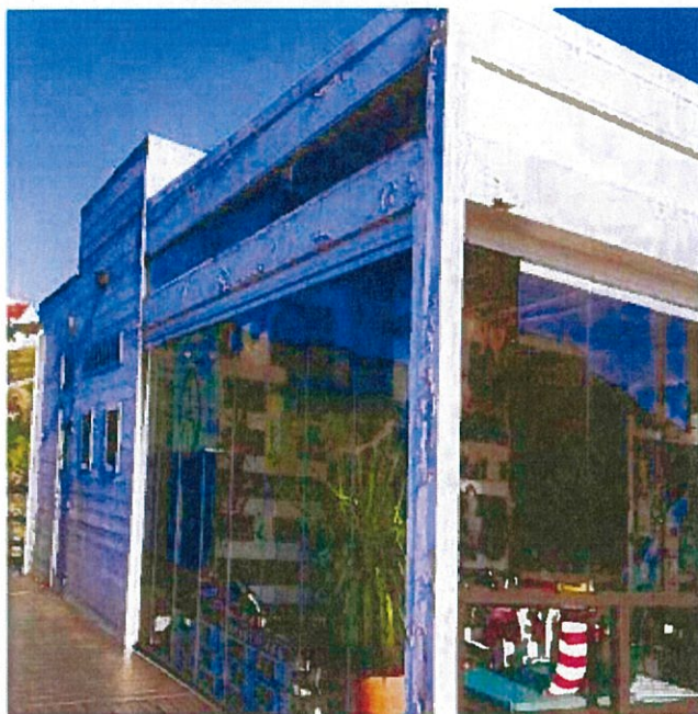
Fig. 1.3 – Fachada lateral com sinais de humidade e deteriorização da pintura
