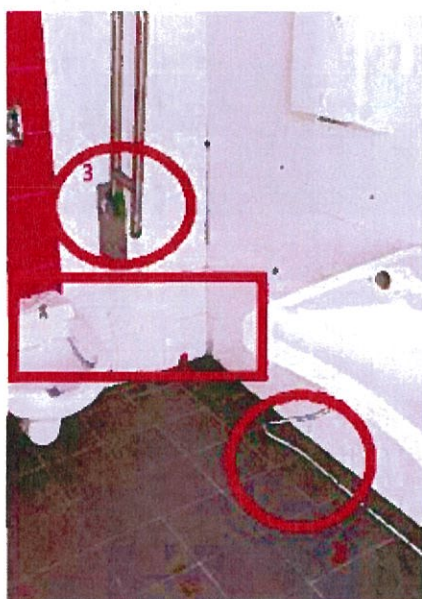
Fig. 1.37 / 1.38 – Casa de banho para pessoas de mobilidade reduzida – Cordão partido (1), sinais de corrosão (2), emendas (3), reparação pontual do teto em gesso cartonado devido a infiltrações (4);
