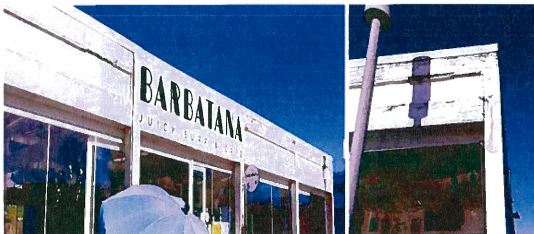
Fig. 1.1 / 1.2 – Fachada principal: deterioração da pintura e sinais de infiltração
