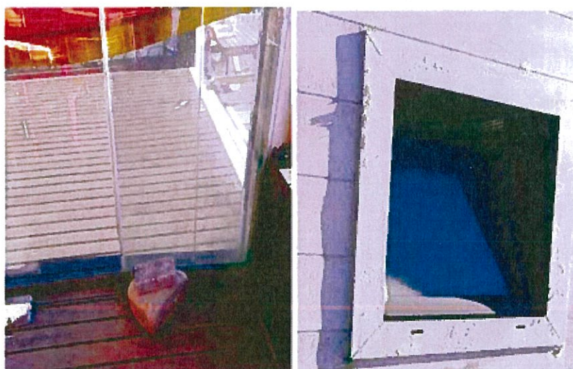
Fig. 1.21 / 1.22 – Envidraçados com problemas no sistema de fecho; janelas das cozinhas sem redes mosquiteiras
