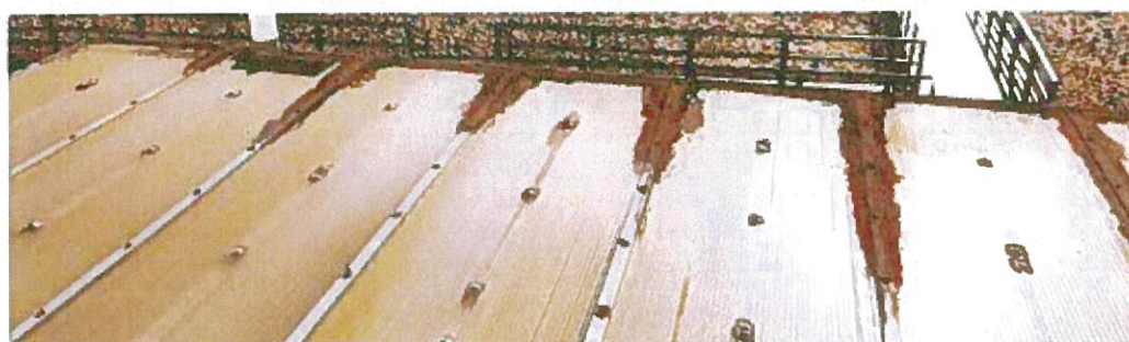
Fig. 1.13 – Placas de polycarbonato (interseção com a fachada principal) – presença de bolor e sujidade
