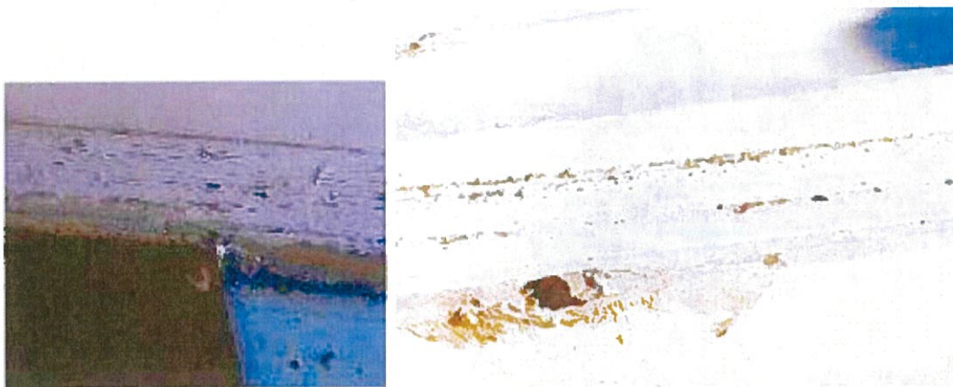
Fig. 1.10 / 1.11 – Pormenores de zonas de maior fragilidade dos painéis sandwich nos remates e fixações
