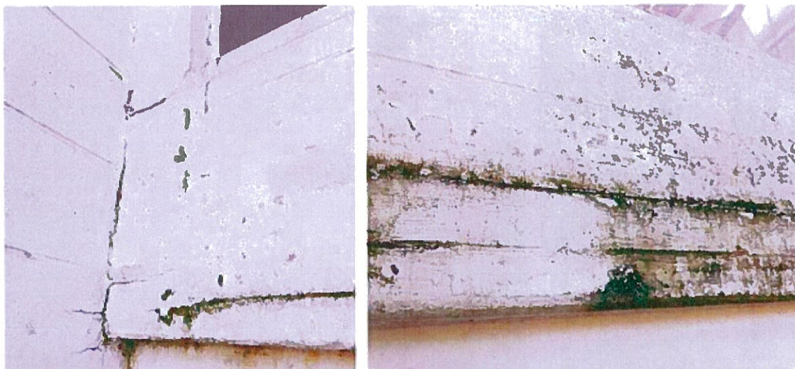
Fig. 1.6 / 1.7 – Pormenores em que revestimento da madeira perdeu propriedades e não cumpre a sua função (bolores e infiltrações várias)
