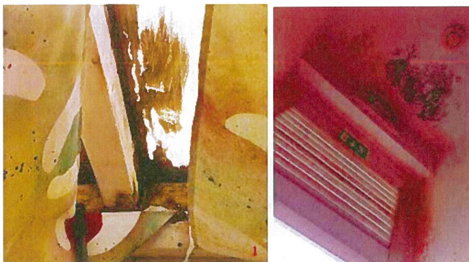
Fig. 1.25 / 1.26 – Estrutura – fachada principal: presença de bolor (1); Interior da Despensa – presença de humidade e infiltrações
