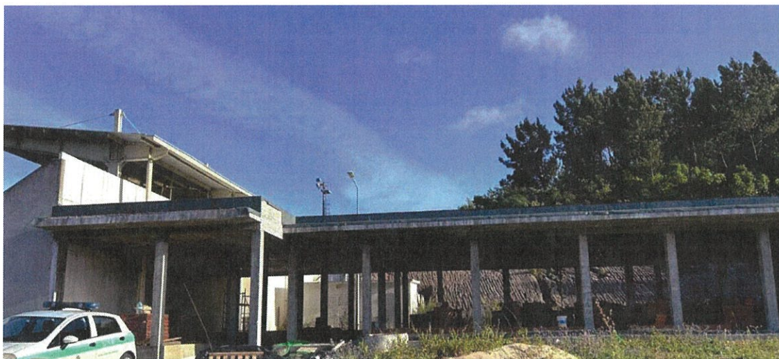
Fig.5 – Ampliação das instalações desportivas.
