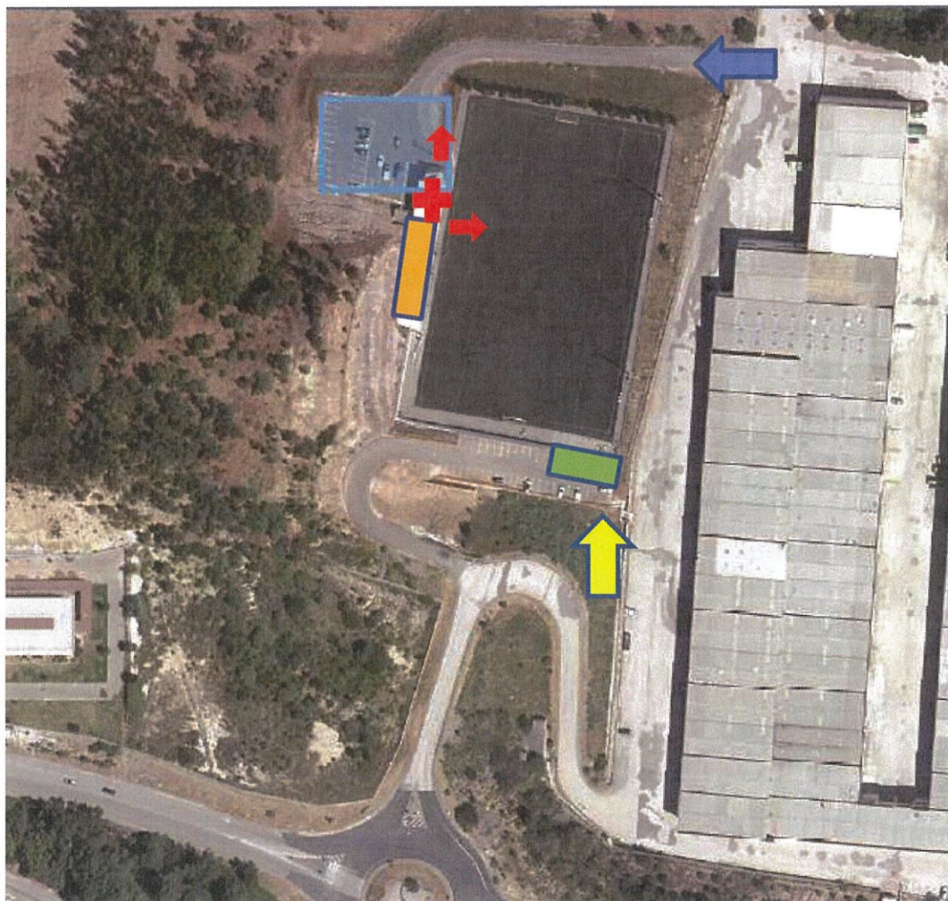
Fig.2 – Vista aérea das instalações desportivas do Estádio Municipal Venda do Pinheiro.
