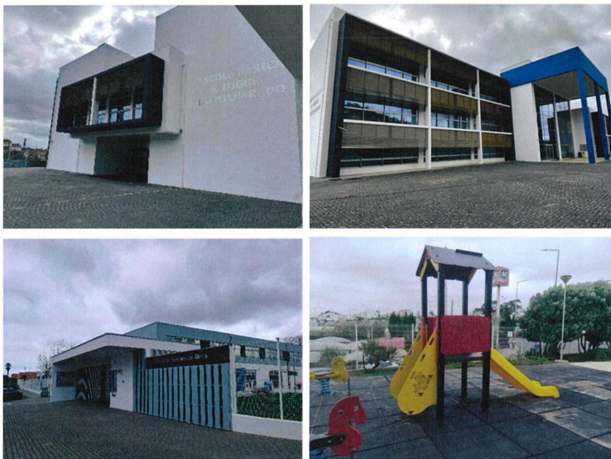
Beneficiações nos edifícios escolares
