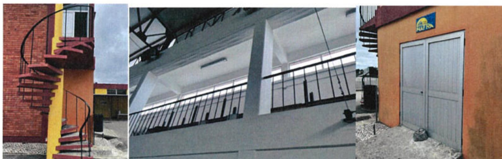
Fotos das escadas, gradeamento da galeria e porta corta fogo existentes
