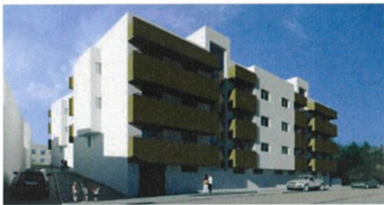
Fachada norte/poente – Rua da Bela Vista
