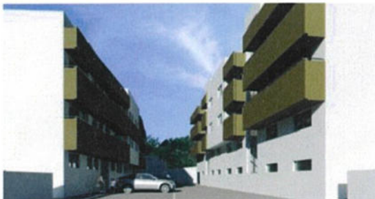
Fachadas dos Blocos A e B
