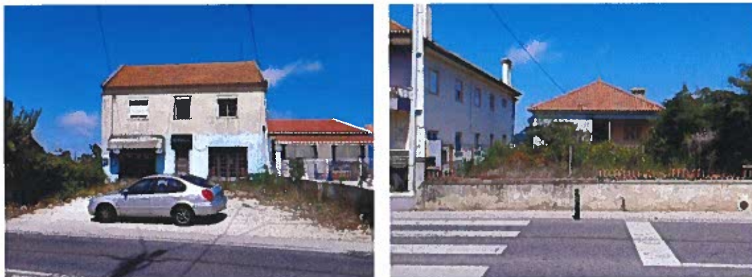
Imagens 26 e 27 – Situação recorrente no Sobreiro: edificações / moradias devolutas e em mau estado de conservação, ambas junto à EN 116, concretamente do lado direito (nascente / nordeste) desta via no sentido Mafra – Ericeira.
