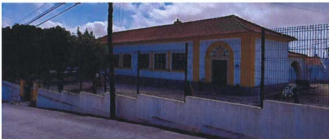
Imagem 35 – Antiga Escola Básica de Caeiros, recentemente reabilitada, sita entre a Rua Principal e a Rua dos Moinhos.
