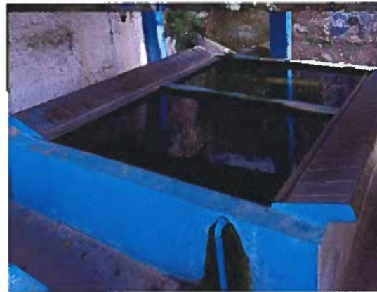
Imagem 8 – Lavadouros, sítos na Rua dos Lavadouros.
