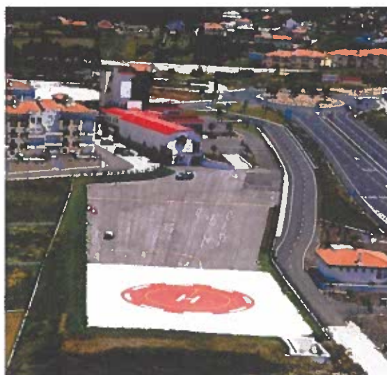
Figura 8 – Vista aérea do Heliporto Municipal
