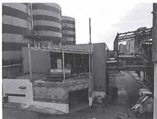
Decurso da obra de ampliação da metanização da CDA da Abrunheira.
