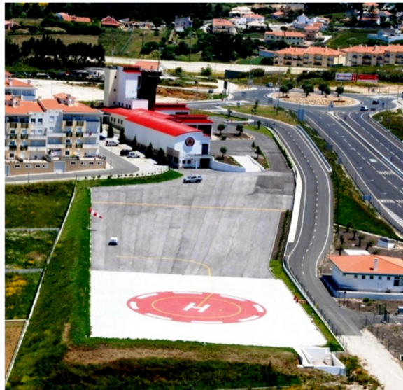
Figura 9 – Vista aérea do Heliporto Municipal
